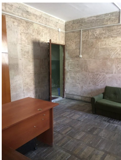
Une porte posée. Les murs ont été préparés avant la peinture
