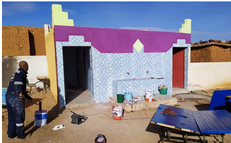
Vue extérieure des toilettes en cours de finition
